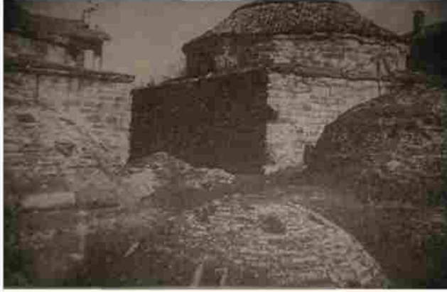
Görsel 6: Balıklı (Rüstem Paşa) Hamamı onarım öncesinden (S. Cener)
