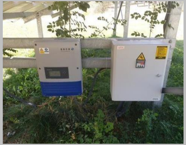
Kampüs elektrik şebekesine bağlı 5Kwh Solar PV Enerji Sistemi. (Kütahya Dumlupınar Üniversitesi, Türkiye)
