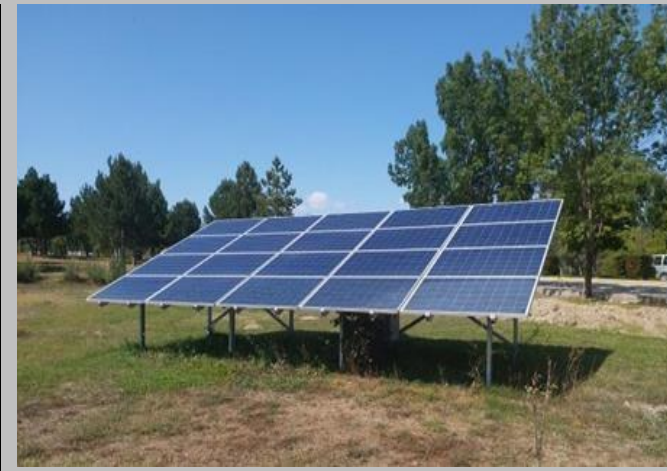
Kampüs elektrik şebekesine bağlı 5Kwh Solar PV Enerji Sistemi. (Kütahya Dumlupınar Üniversitesi, Türkiye)
