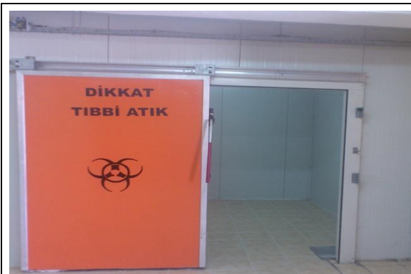
Tıbbi Atık Depolama
