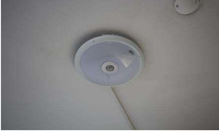
Sensörler (Otomatik Aydınlatma Kontrolü) Led Işıklar (Yüksek Verimli)
