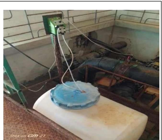
İçme ve kullanma suyu için klorlama yapılmaktadır (Kütahya Dumlupınar Üniversitesi, Türkiye)
