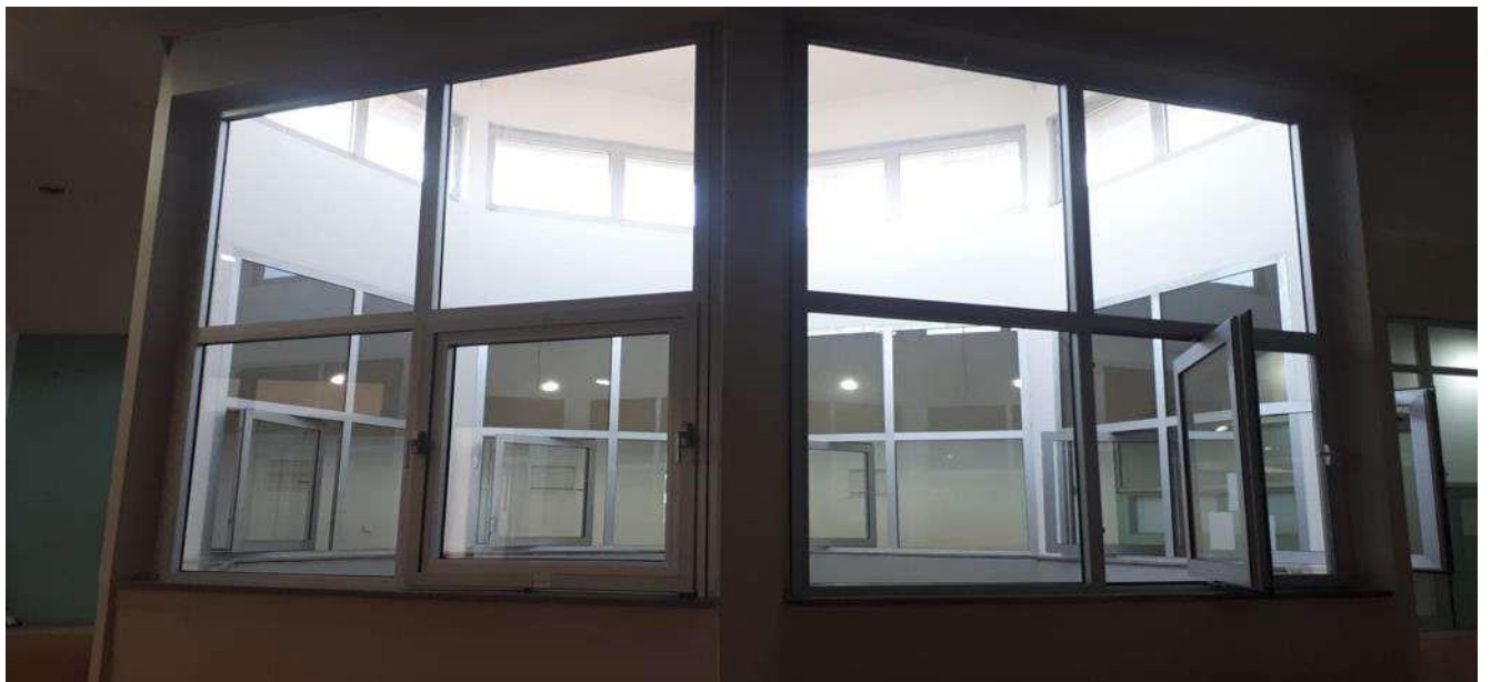
Rektörlük Binası, Kalite Koordinatörlüğü (Kütahya Dumlupınar Üniversitesi, Türkiye )
