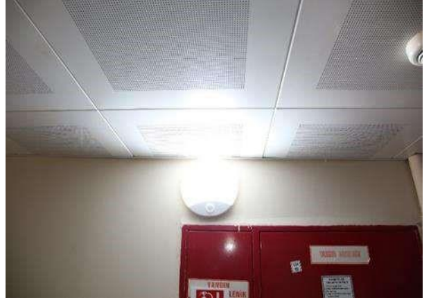
Sensörler (Otomatik Aydınlatma Kontrolü) Led Işıklar (Yüksek Verimli)
