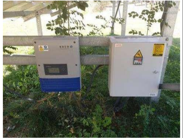
Kampüs elektrik şebekesine bağlı 5Kwh Solar PV Enerji Sistemi. (Kütahya Dumlupınar Üniversitesi, Türkiye)
