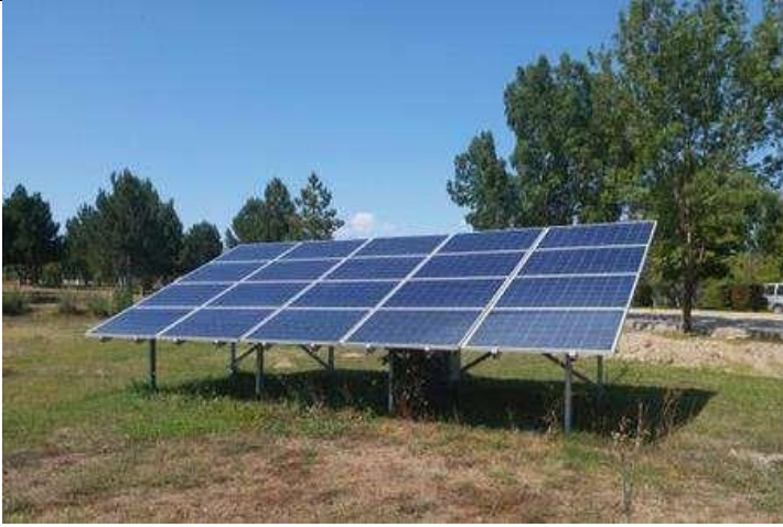
Kampüs elektrik şebekesine bağlı 5Kwh Solar PV Enerji Sistemi. (Kütahya Dumlupınar Üniversitesi, Türkiye)
