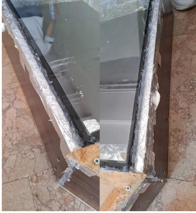
Şekil 25 Silikon ile cam montajı
