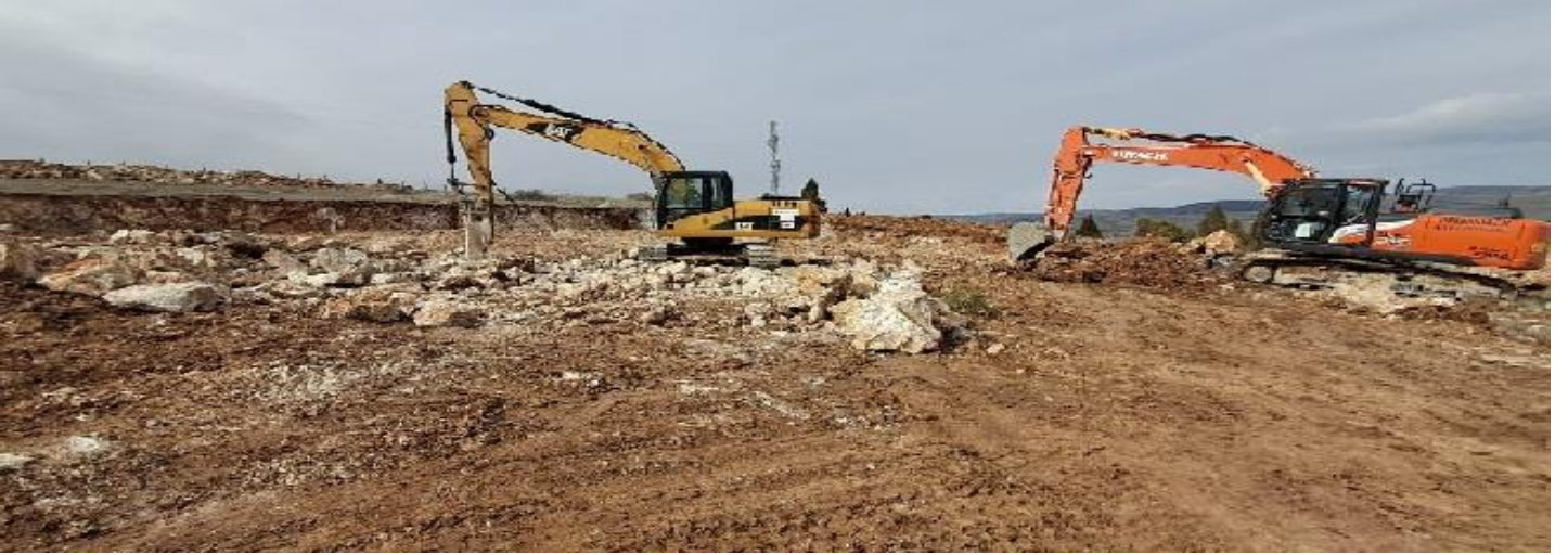
3000 m 3 lük Su Deposu Kazısı
