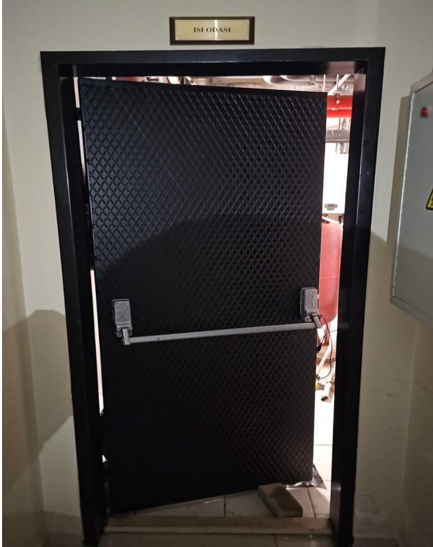
Dumlupınar Konukevi kazan daireesi kapısı vangına davanıklı hale getirildi.
