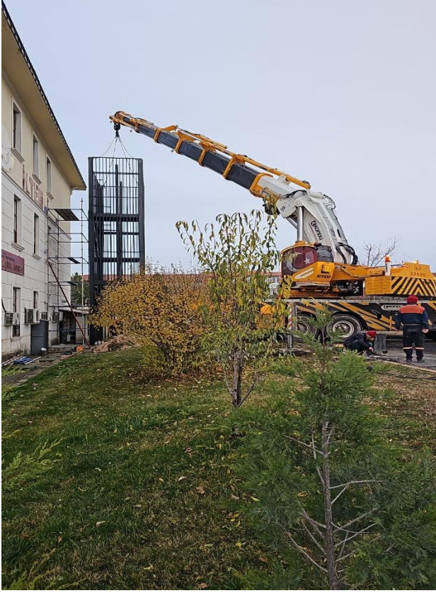
Zafertepe Konukevi (İLTEM) binası Yangın merdiveni
