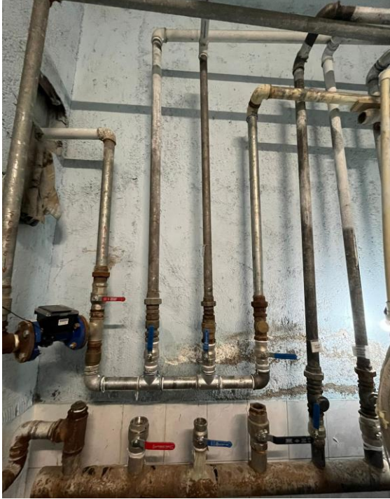
SKS Ana Bina Kazan Dairesi Kollektör Tadilatı Zafertepe Misafirhanesi Hattı
