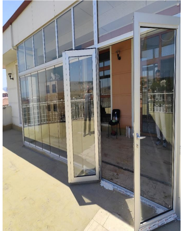
Kütüphane GSF Binasına Alüminyum Kapı Kasa Cam İmalatı
