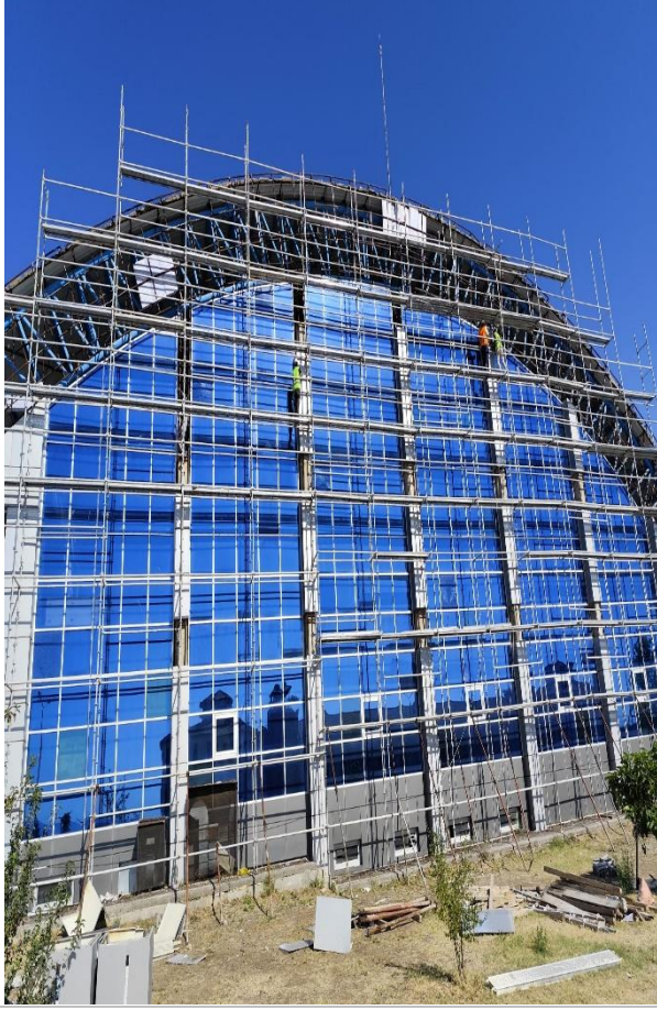
GSF Binası Saçak Alnı+Altı Saç Kaplama Yapımı
