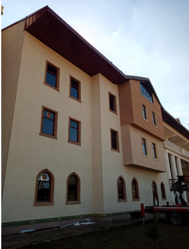
GSF Binası Saçak Alnı+Altı Saç Kaplama Yapımı
