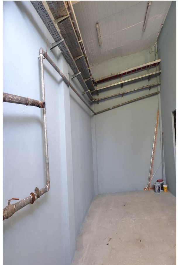
Rektörlük Kazan Dairesi Tadilatı
