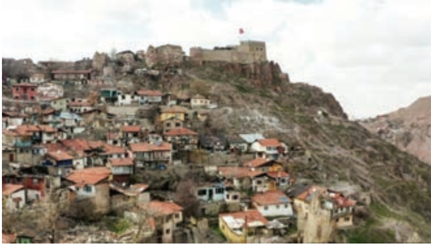
Görsel 3. Ankara Kalesi Civarı Kentsel Dönüşüm Çerçevesinde Yıkılmadan Önceki Görünümü
