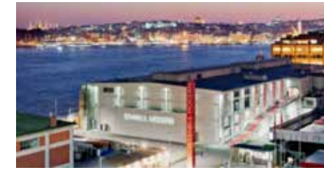
Resim 16. İstanbul Modern Sanat Müzesi Eski Binası
