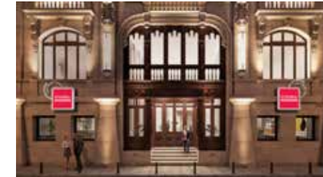
Resim 17. İstanbul Modern Sanat Müzesi Geçici Binası
