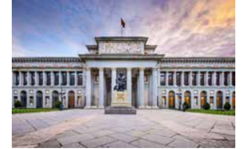
Resim 11. Prado Müzesi Dış Cephe Mimari Görünümü
